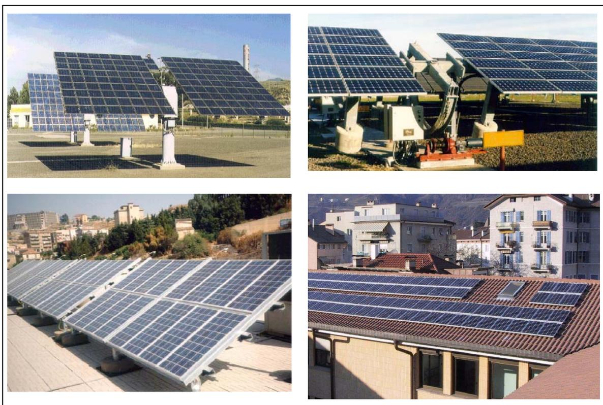
**Figura 4.4 - Varie tipologie di strutture di sostegno per moduli fotovoltaici: Inseguimento solare su due assi, inseguimento su un asse, struttura inclinata su cavalletti e struttura inclinata su falda**
