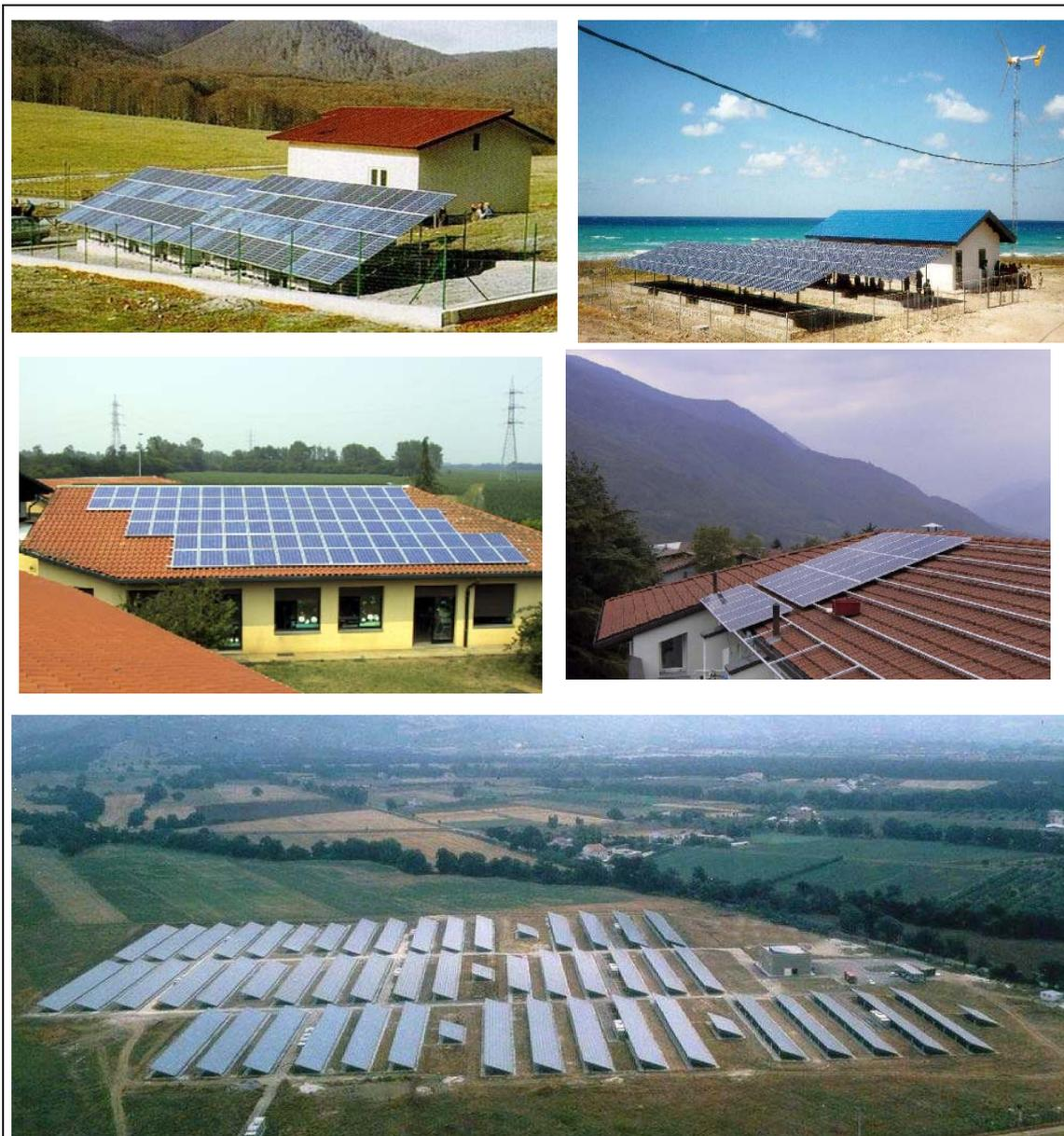
**Figura C.7 – Varie tipologie di impianti fotovoltaici: alimentazione di utenza isolata, alimentazione di comunità isolata, tetti fotovoltaici e centrali fotovoltaiche**
