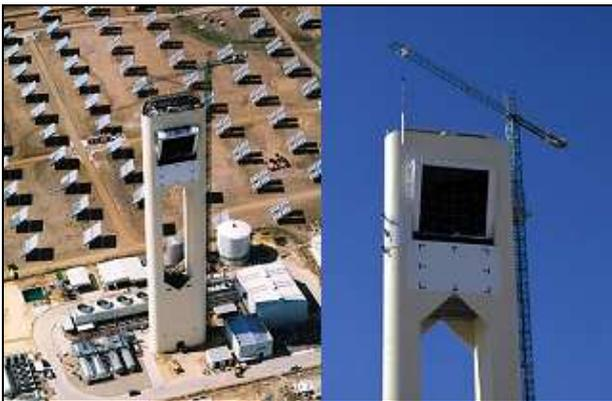
**Figura 59:** PS10, foto della torre e del ricevitore [51].
