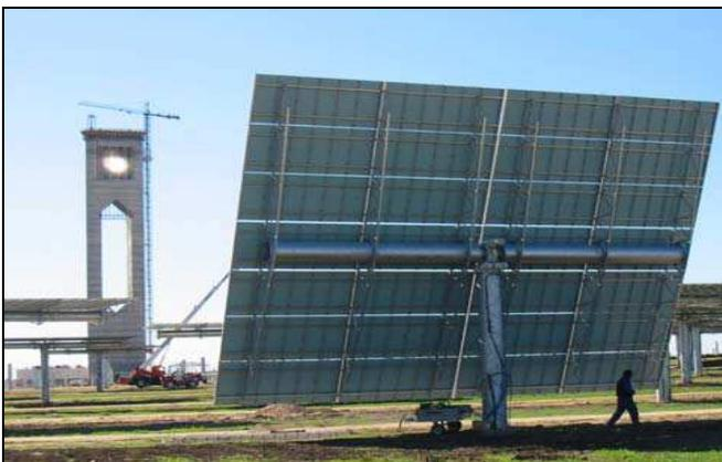
**Figura 61:** PS10, foto della torre e del ricevitore [51].
