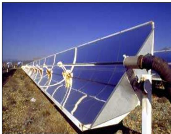
**Figura 28:** Parabolic trough, foto del collettore Acurex [47].
