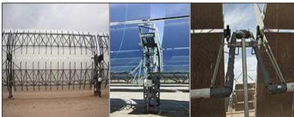
**Figura 30:** Parabolic trough, foto della struttura, della guida e dell'interconnessione del collettore LS-3 [47].
