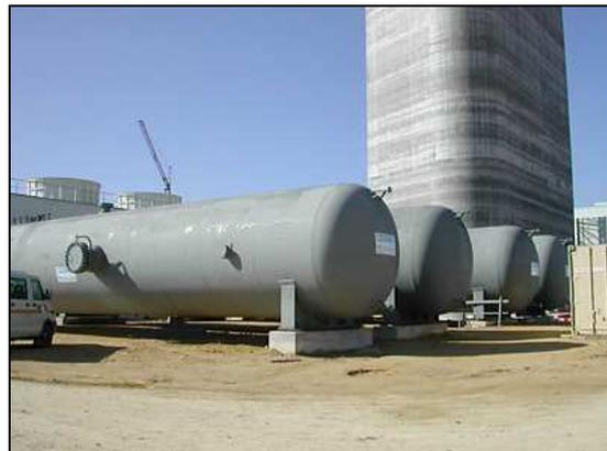
**Figura 60:** PS10, foto del sistema di accumulo [51].
